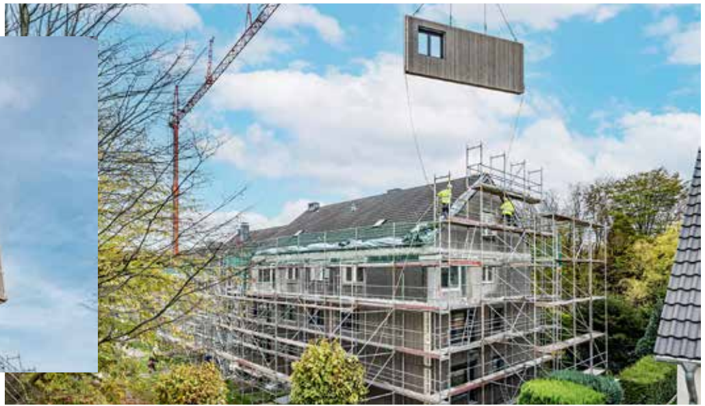
Beispiel für eine serielle Sanierung im Vergleich zur konservativen Alternative an einem Gebäude in Bochum. Foto: ecoworks
