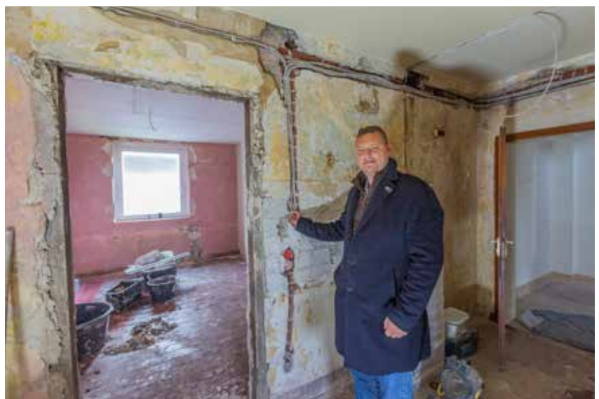
Der Zustand während der Kernsanierung in der Herkendellstraße.
