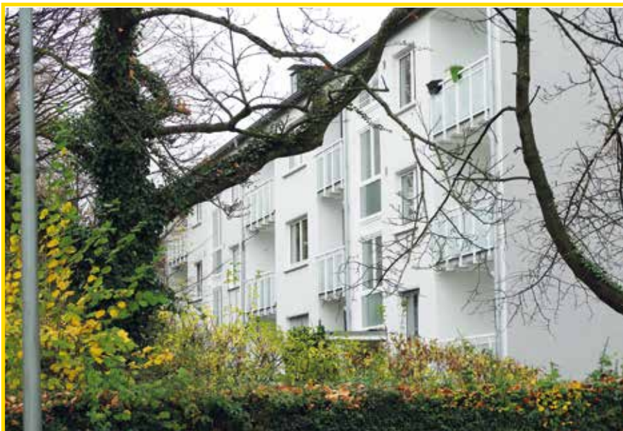
Wurde von aussen bereits saniert: Lohmühlenstraße.
