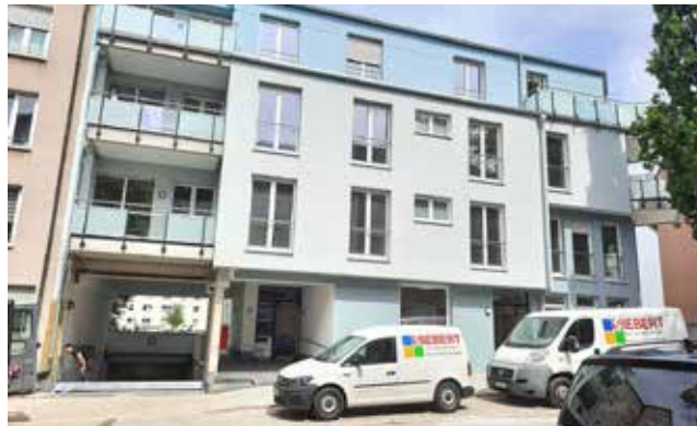
Fast fertig, dre Neubau der WBG Horst in der Marken-/Heinrich-Heine-Straße.
